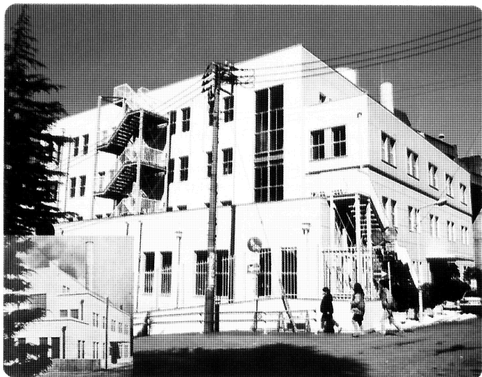
増階前の旧2号館
