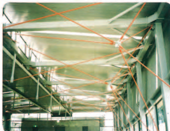
あやとり状のケーブルで囲まれた駅舎空間
