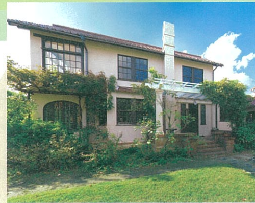
駒井家住宅(駒井卓・静江記念館) 画像提供：日本ナショナルトラスト
